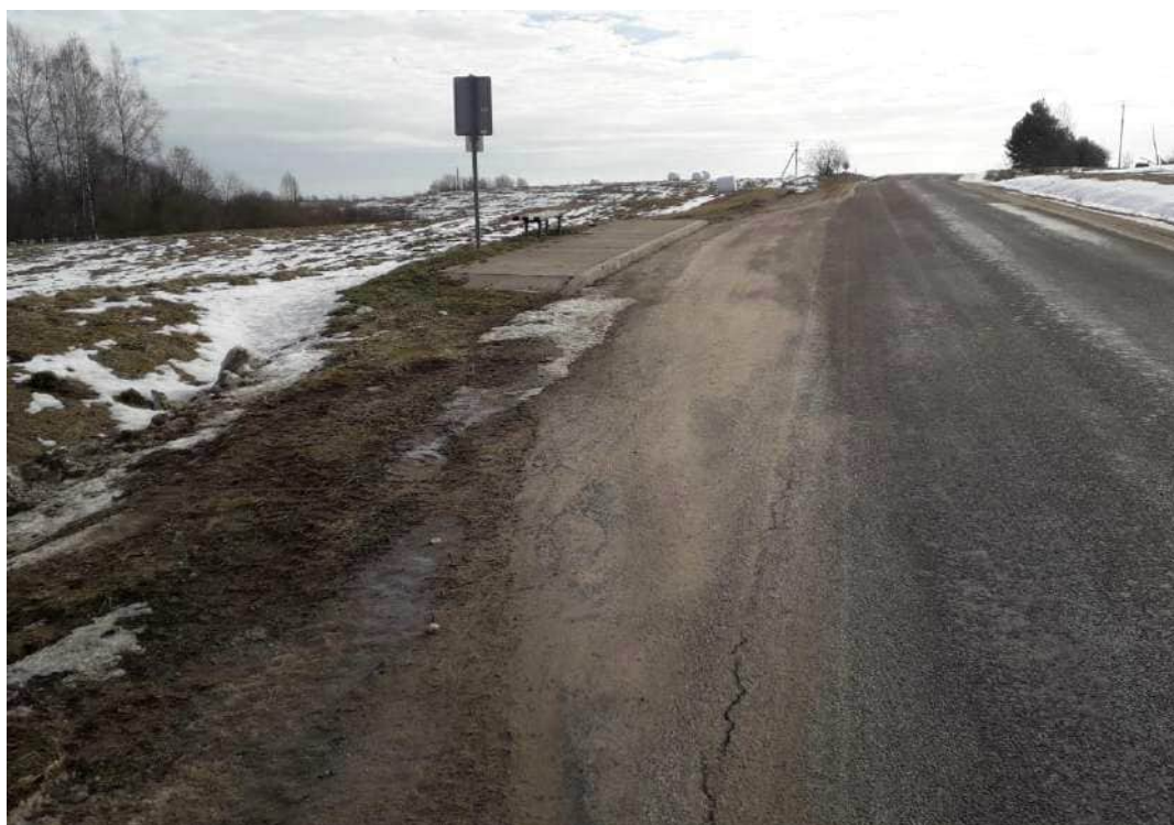
4 pav. Autobusų sustojimo aikštelė
