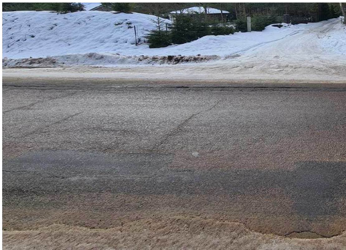
2 pav. Važiuojamojoje dalyje susidaręs plyšių tinklas
